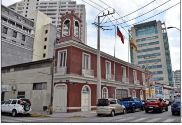
Construido en 1877, principalmente con pino oregón, es el cuartel de Bomberos más antiguo de Iquique. Su origen responde al terremoto y maremoto de ese año.
